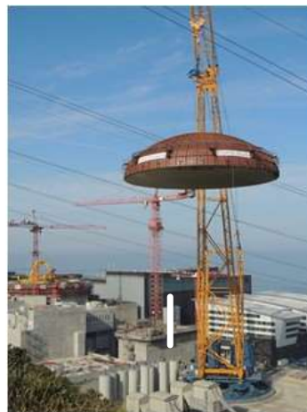
Pose du dôme
