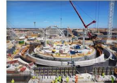
Fin 2027 : 1 er béton de l'îlot nucléaire J0 unité n°1 (2029 pour l'unité n°2)
