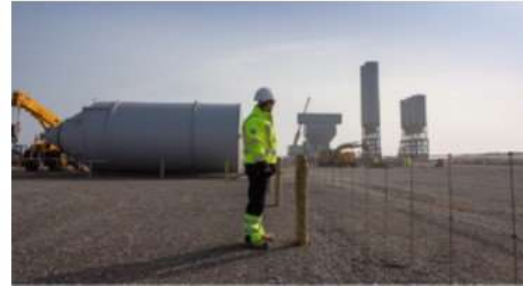
Travaux de terrassement du bloc usine Mobilisation significative du génie civiliste
