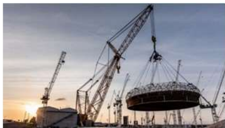
Arrivée de la grue type « big Carl » sur le chantier
